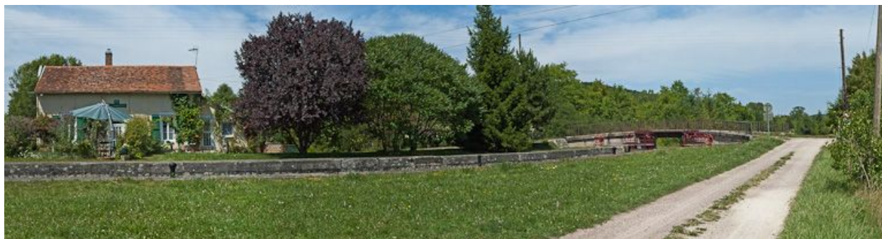
Vue d'ensemble du site d'écluse.
