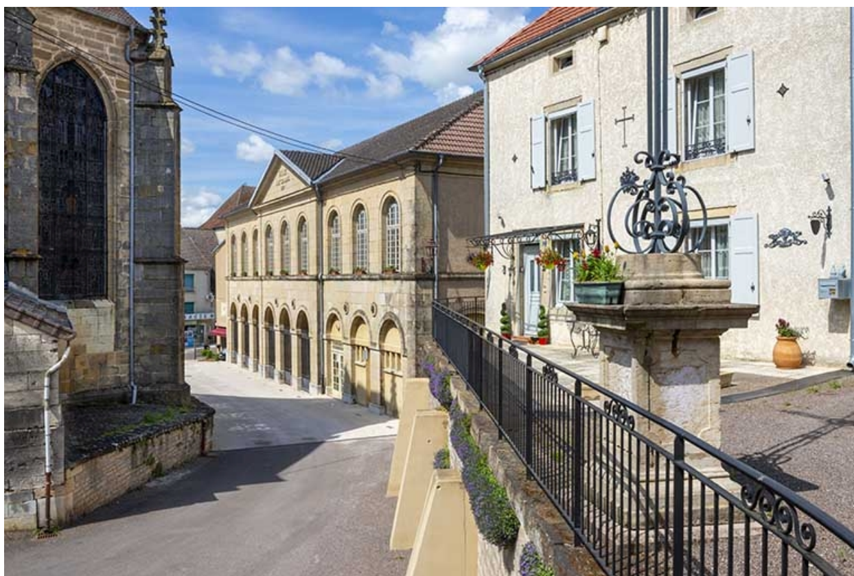
Vue éloignée depuis le sud.
