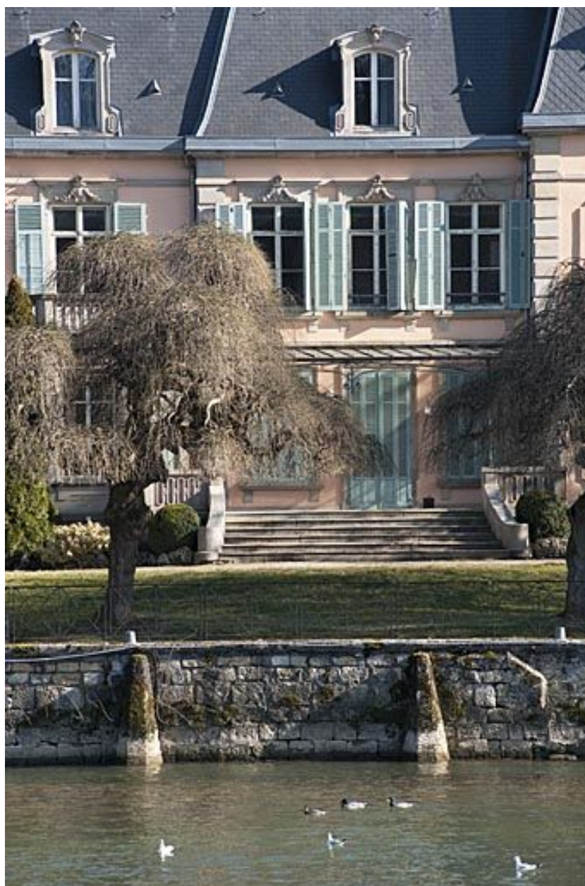
Détail de la façade ouest.
