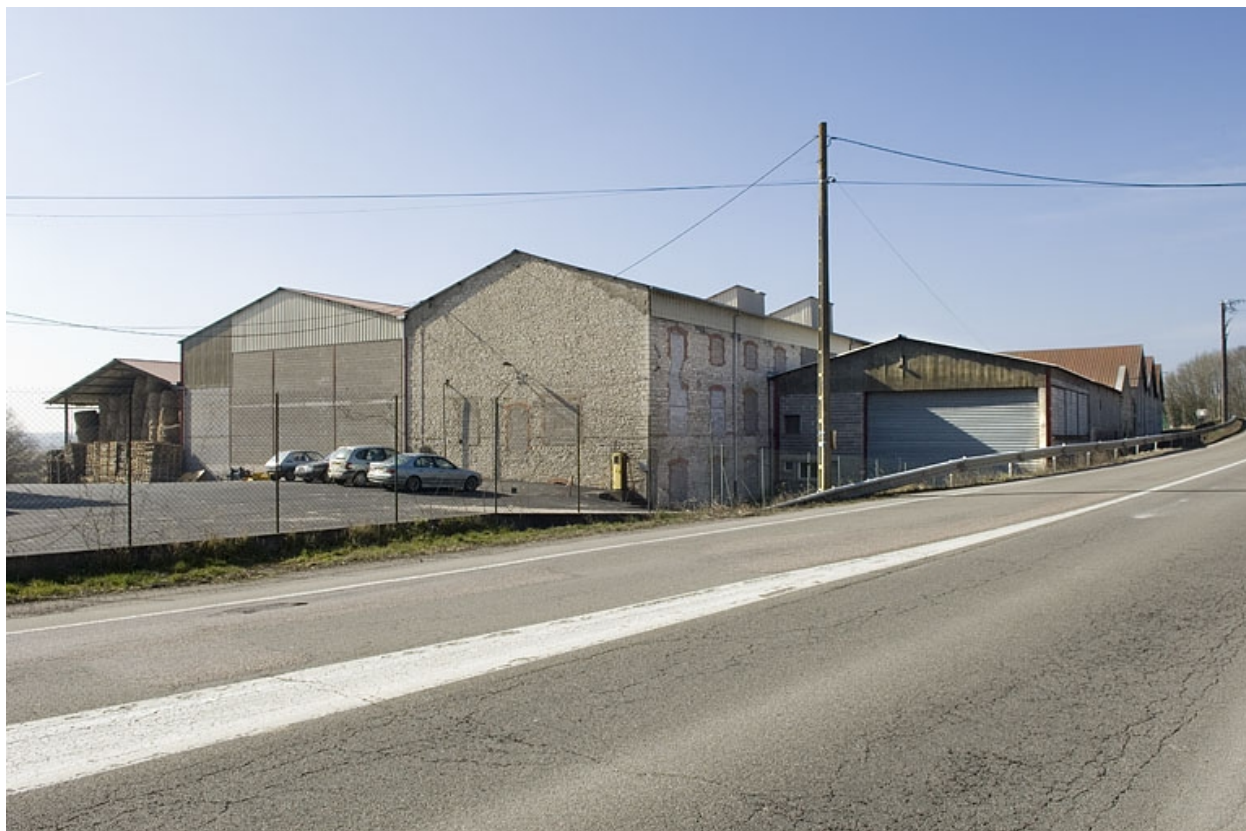
Atelier de fabrication depuis le nord.
