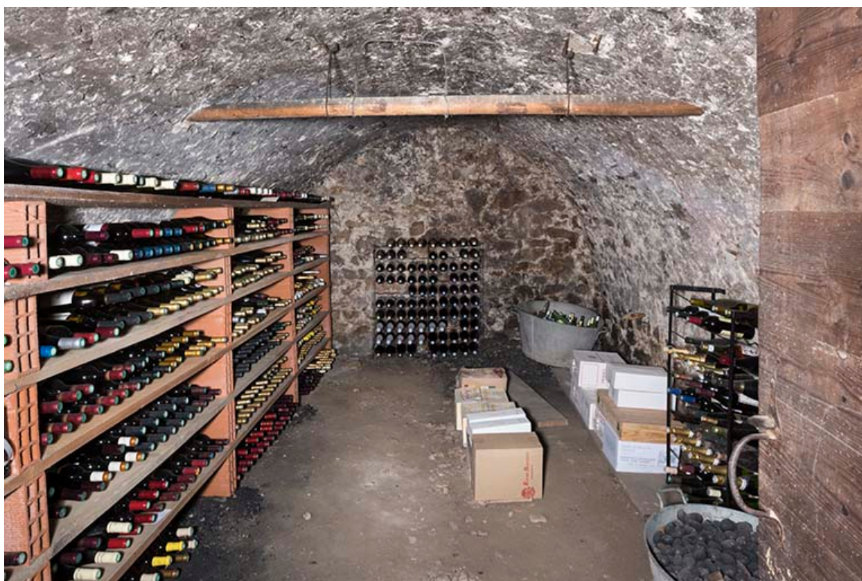
Deuxième étage de soubassement : cellier.
