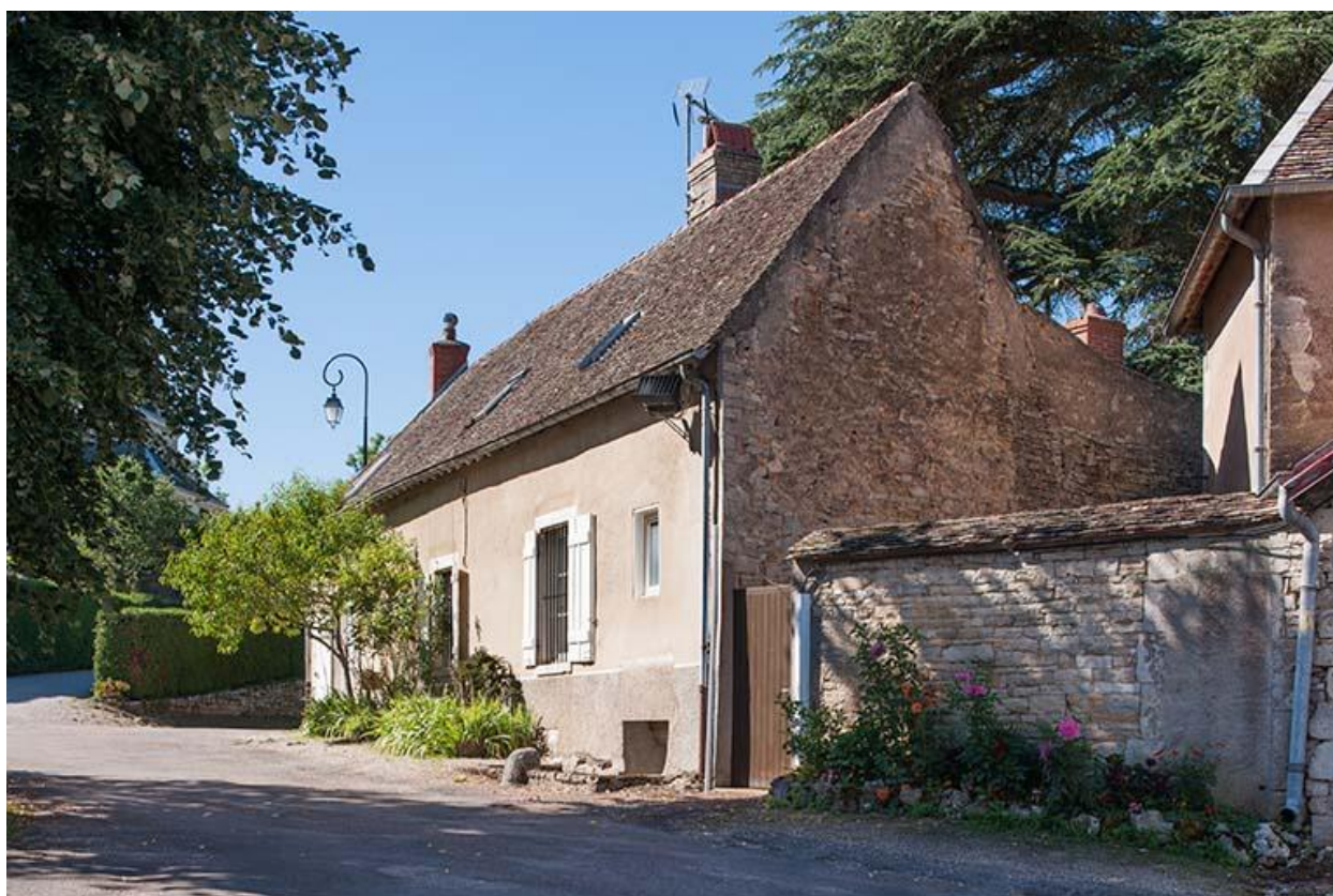
Bâtiment situé à l'ouest du presbytère
