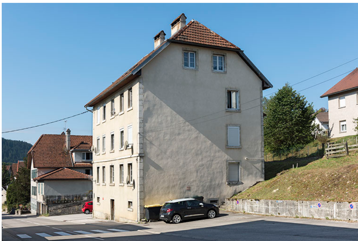
Façades antérieure et latérale droite.
