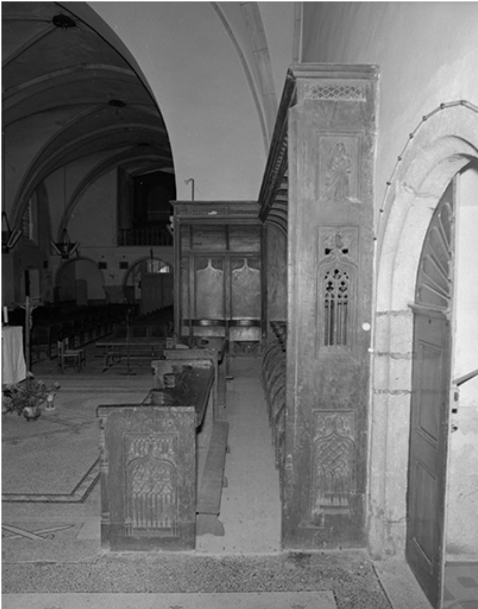
Stalles nord, vue générale depuis l'est.
