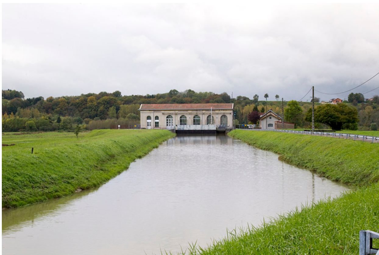
La centrale depuis le bief d'amenée.
