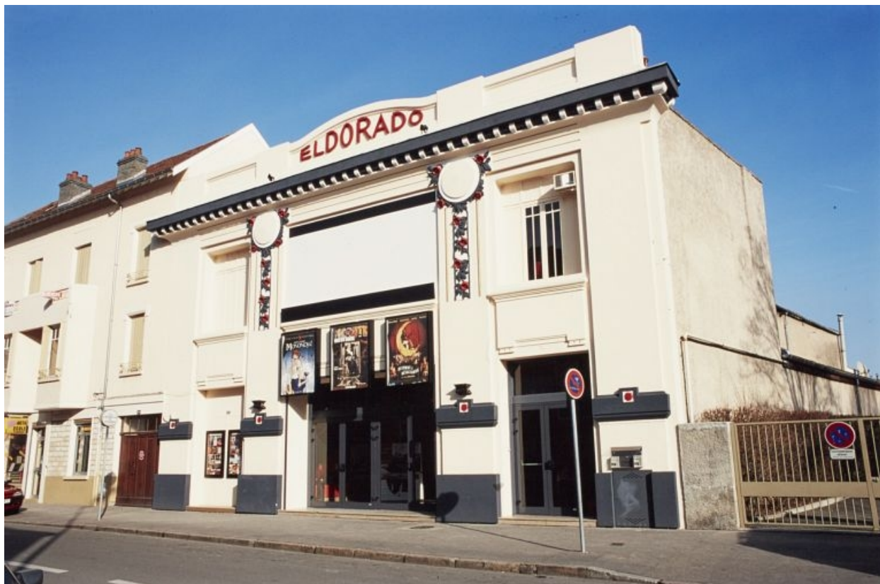
Elévation sur rue en 2000.
