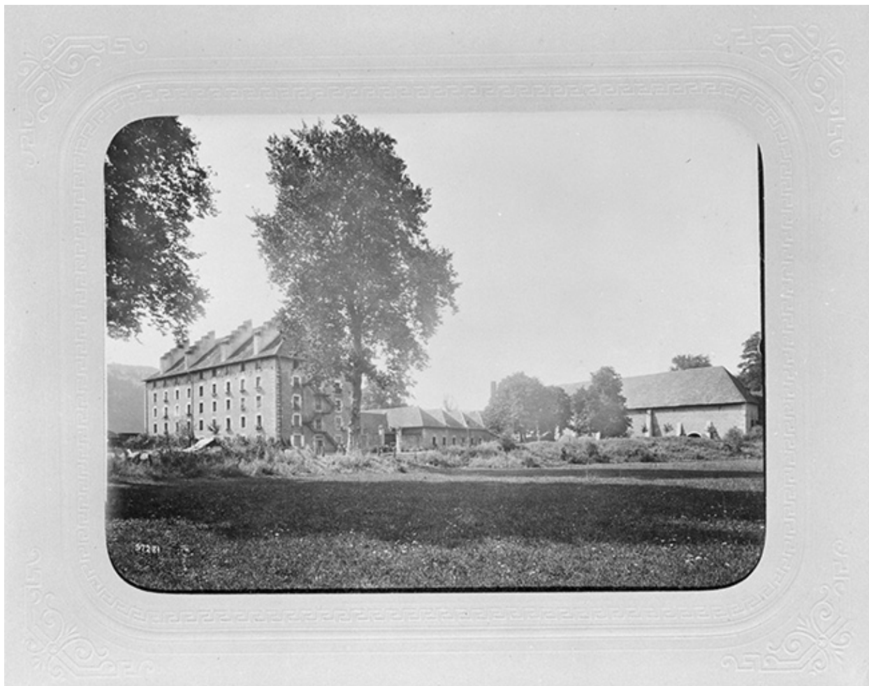
Usine de Buillon, 1899-1900.
