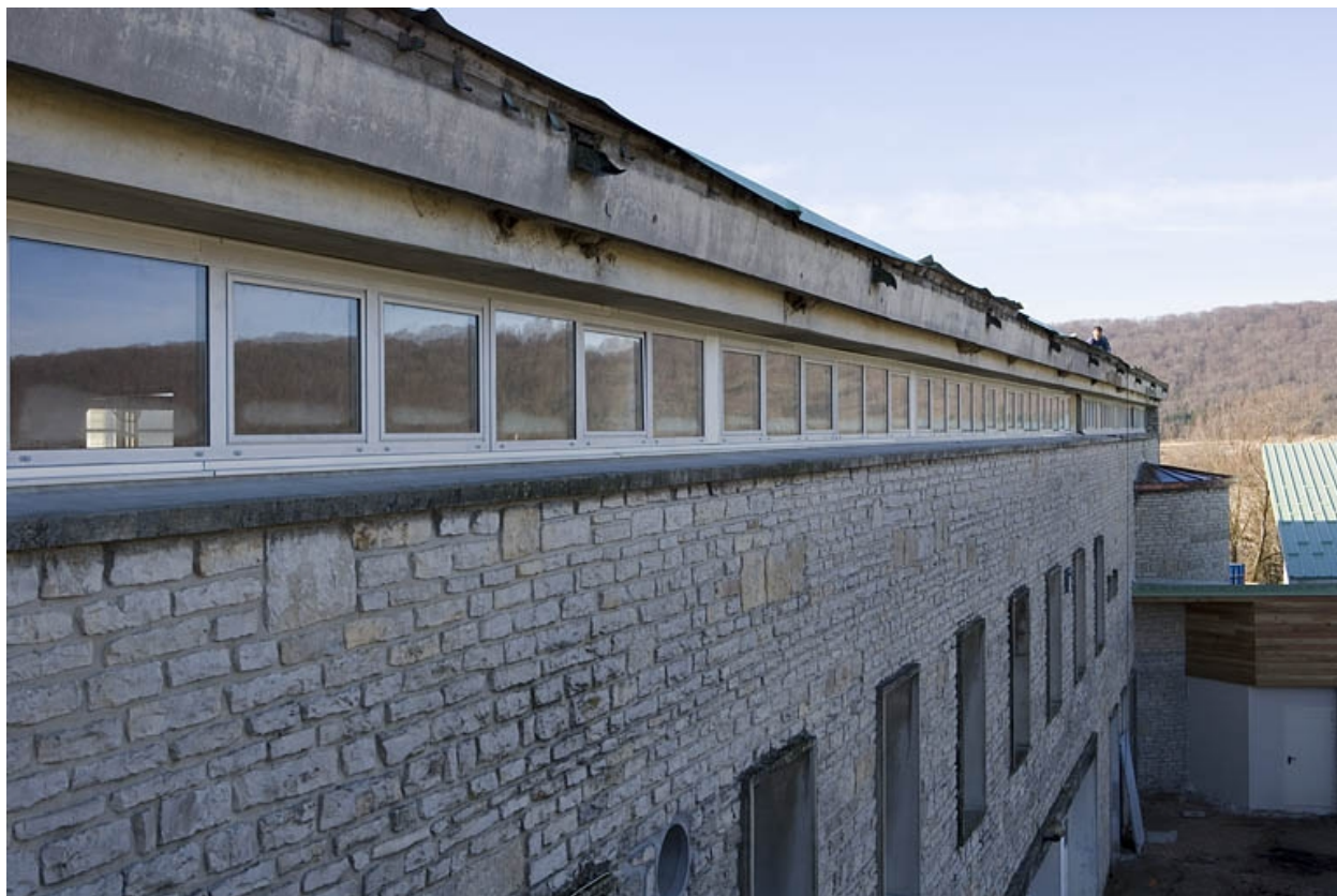
Façade : coursive intérieure, baies.
