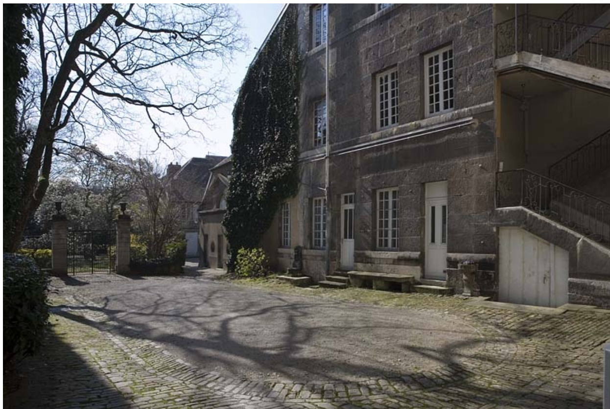
Vue d'ensemble de l'aile sur cour.
