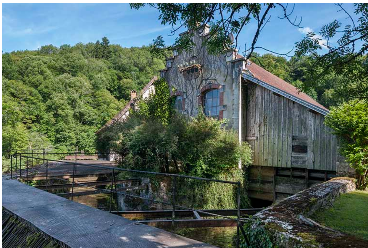
Prise d'eau, centrale hydroélectrique et bâtiment d'eau.
