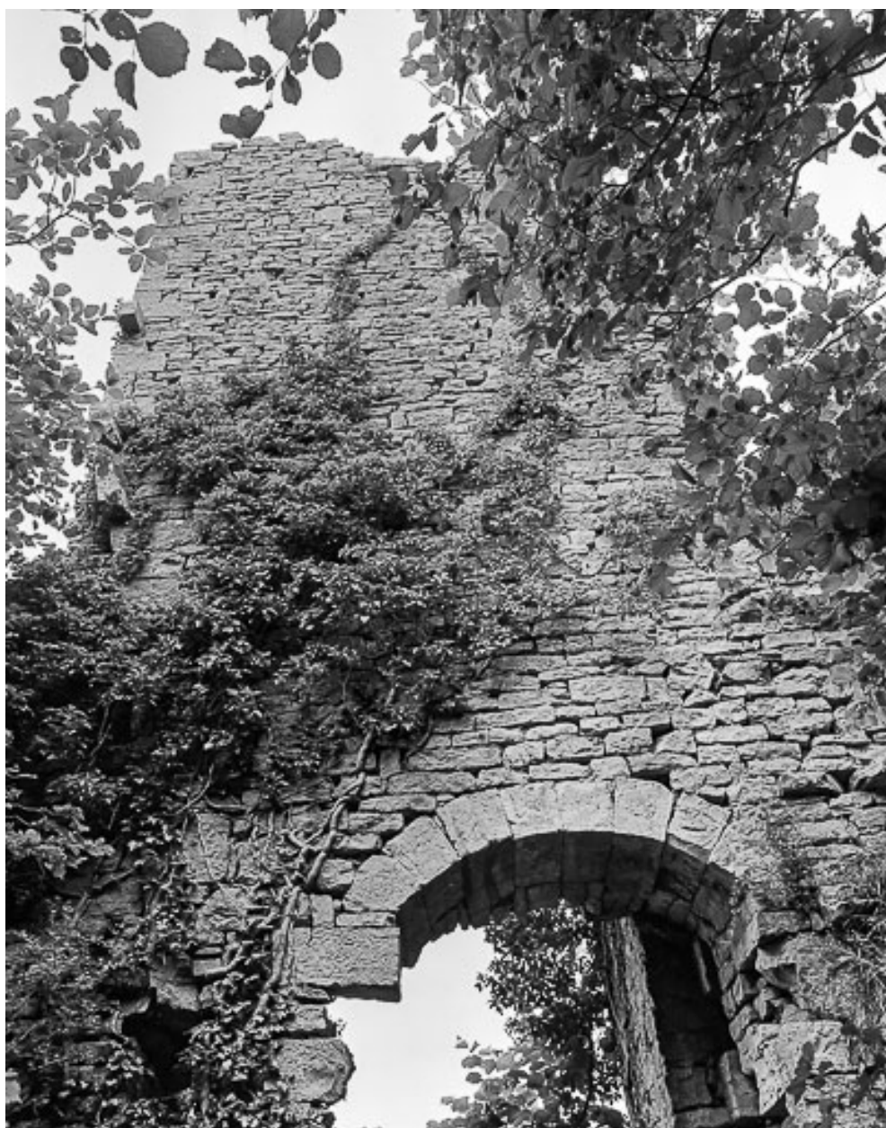
Vue extérieure du donjon.
