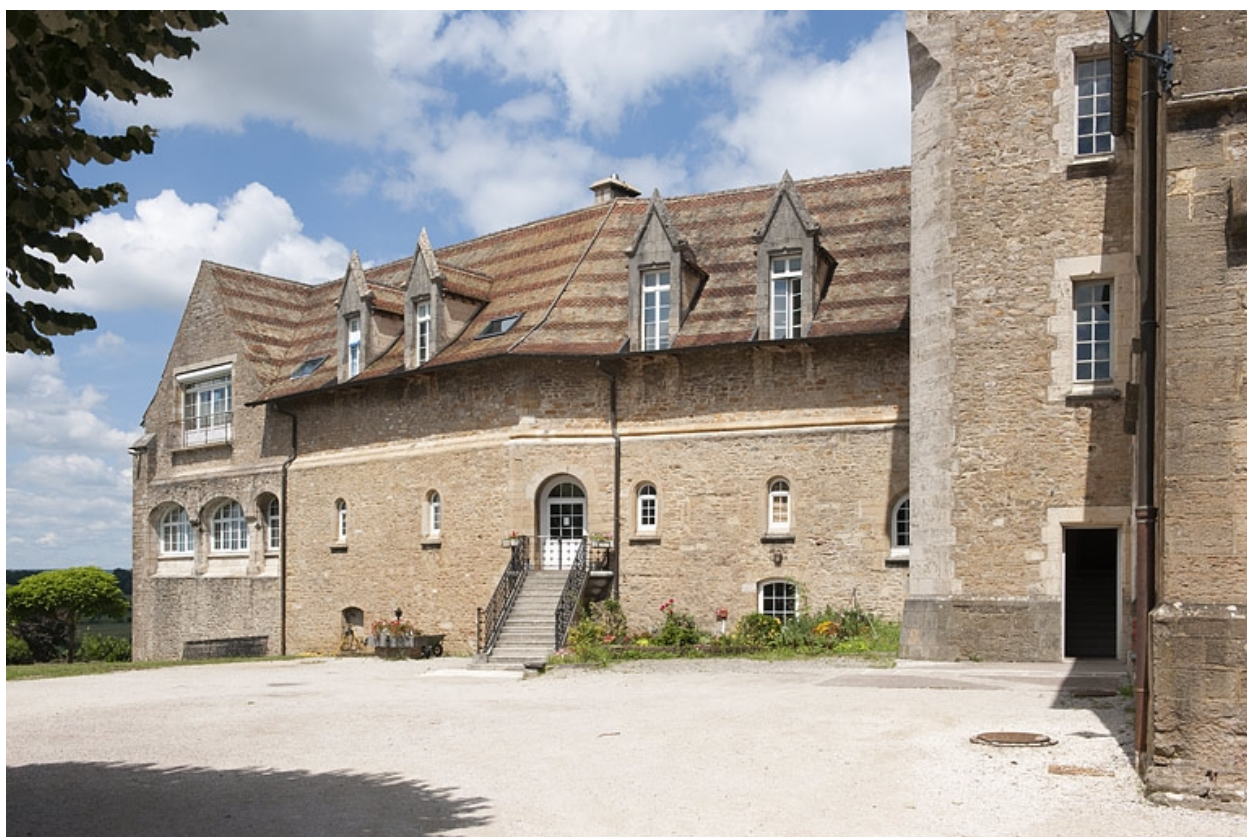
Bâtiment (C), vue depuis la cour.
