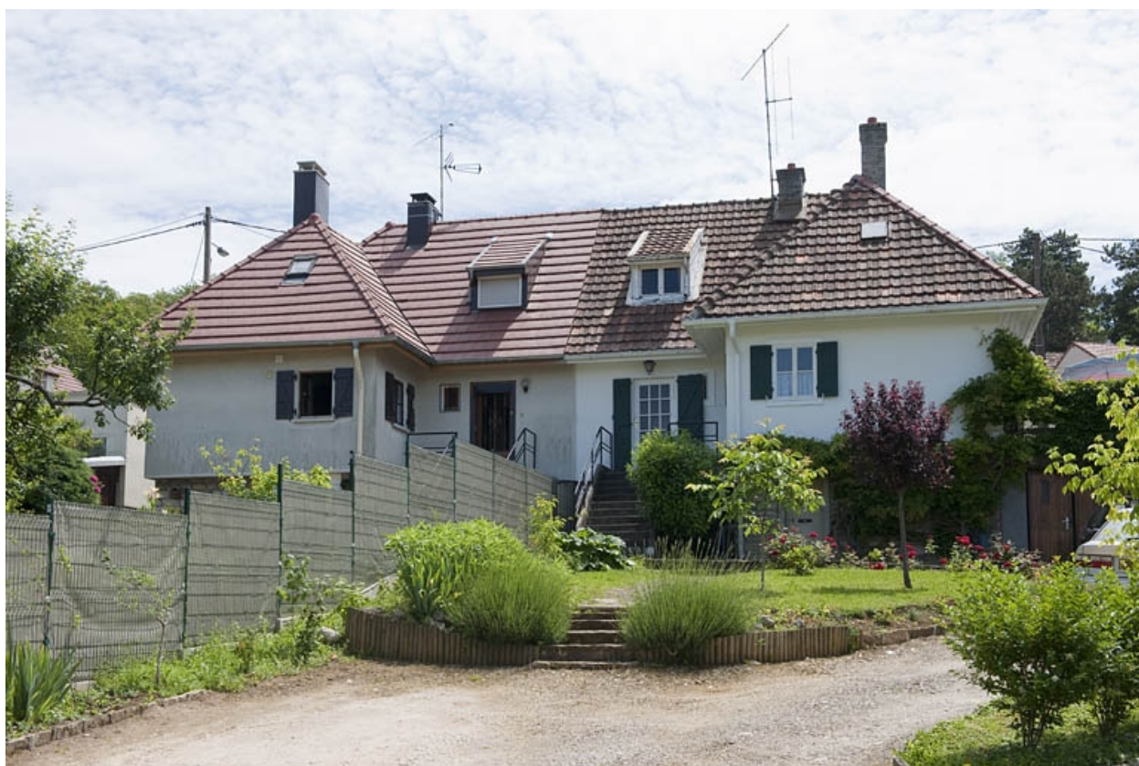
Maisons jumelles rue Raoul Delattre. Façades ouest.
