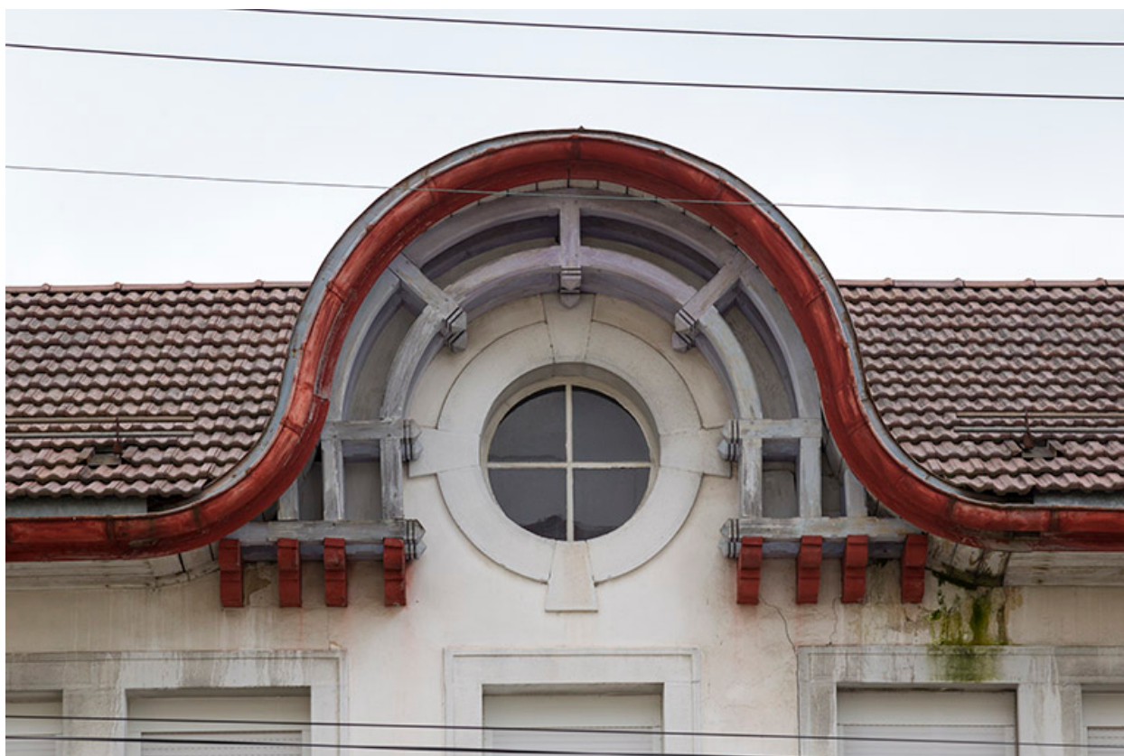
Façade antérieure : oculus éclairant le comble.
