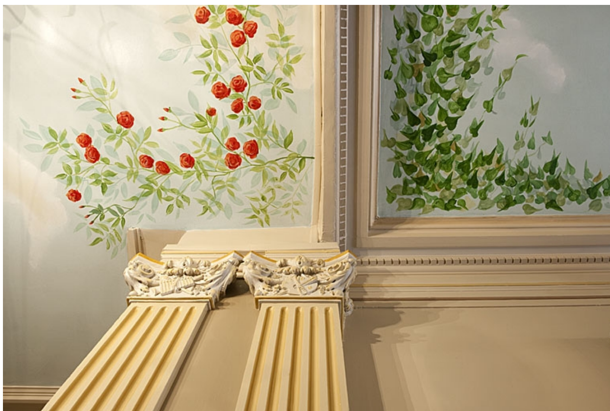
Détail du décor du plafond.
