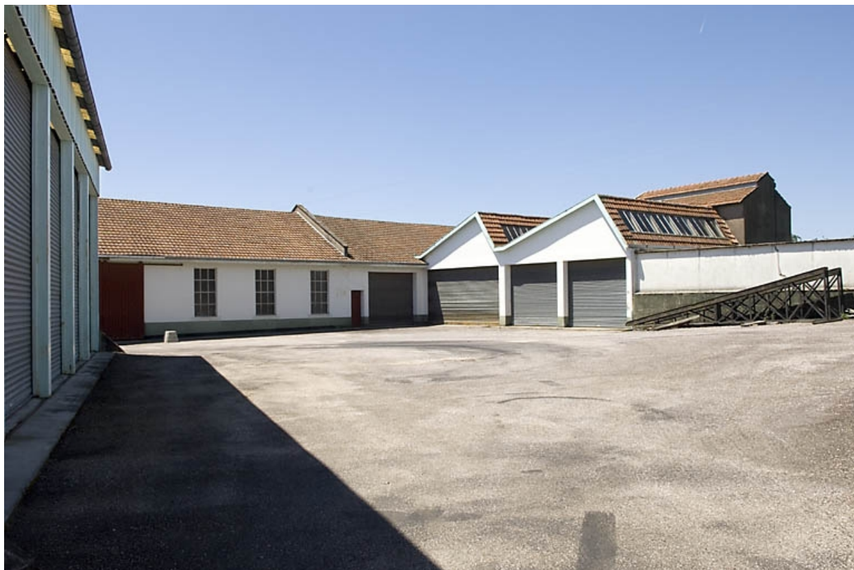
Extension nord de l'usine. Garages.
