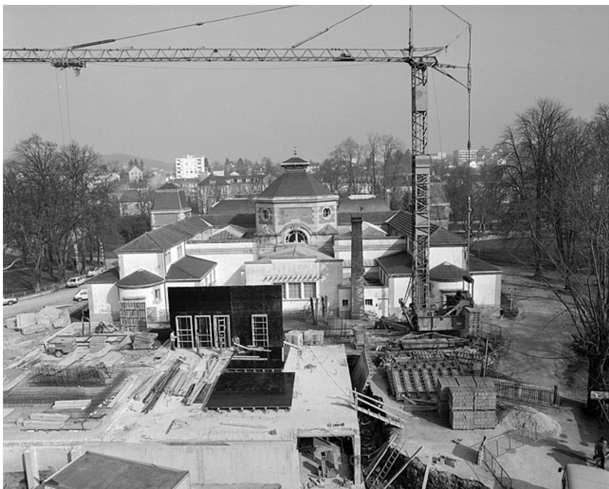
Travaux d'agrandissement, photographie prise en 1983.
