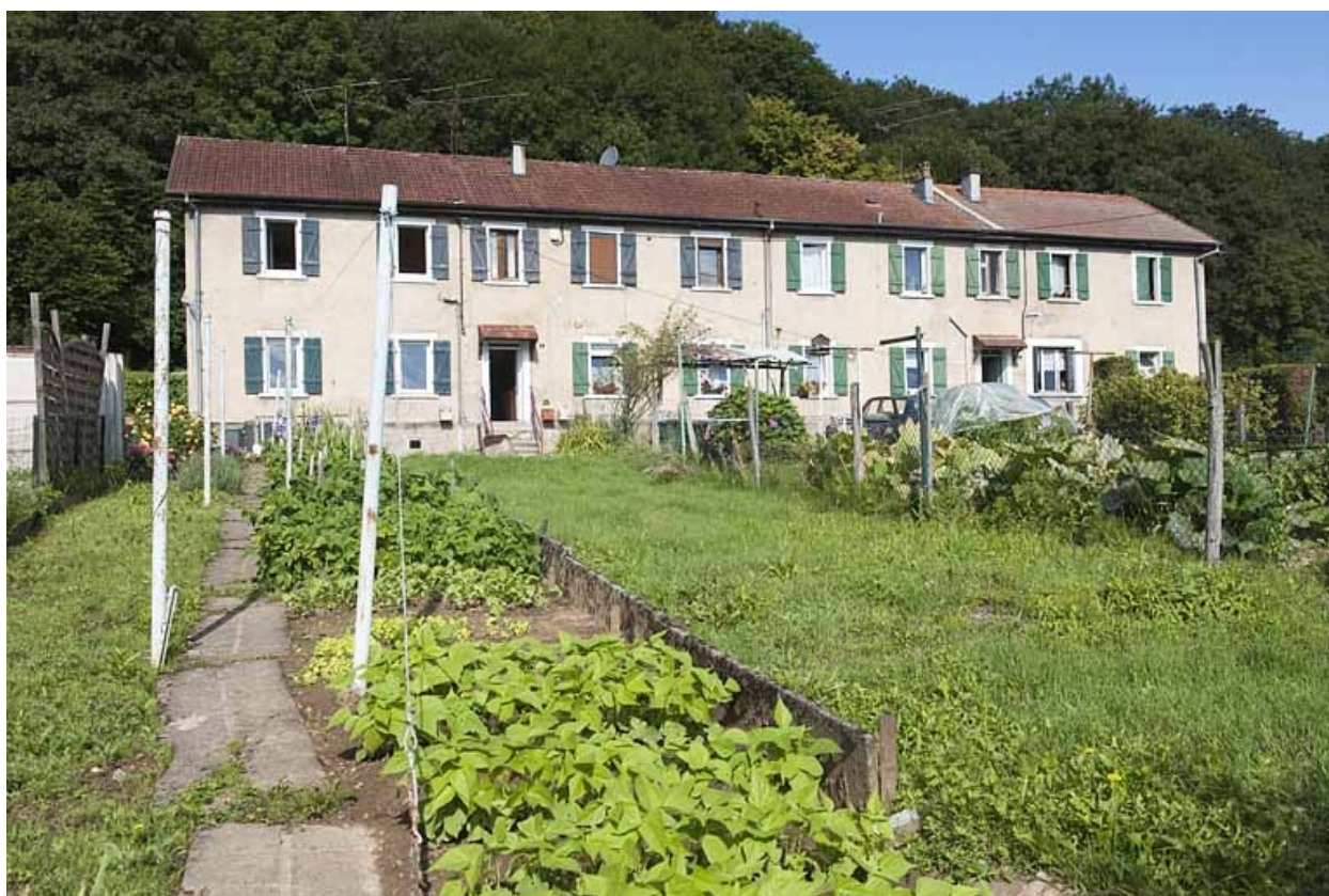
Habitation à 8 logements. Façade antérieure.
