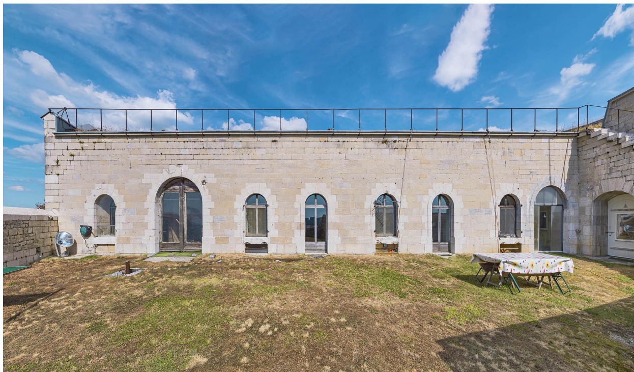
Vue générale de la façade postérieure.
