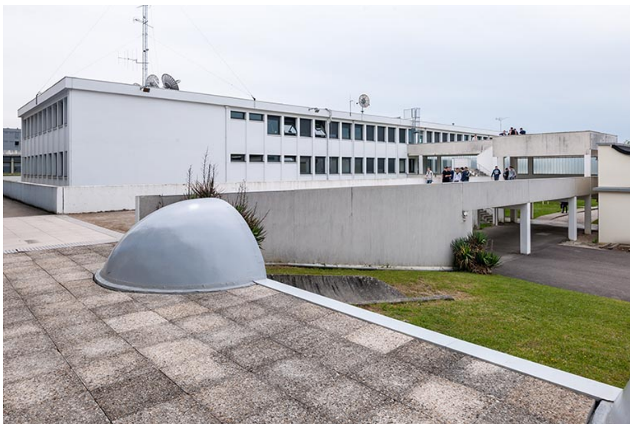
Externat : façade postérieure de l'ancien externat réaménagé.
