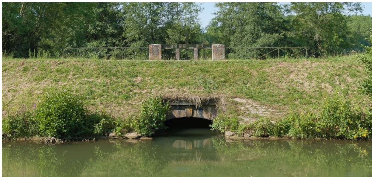
Sortie du déversoir.
