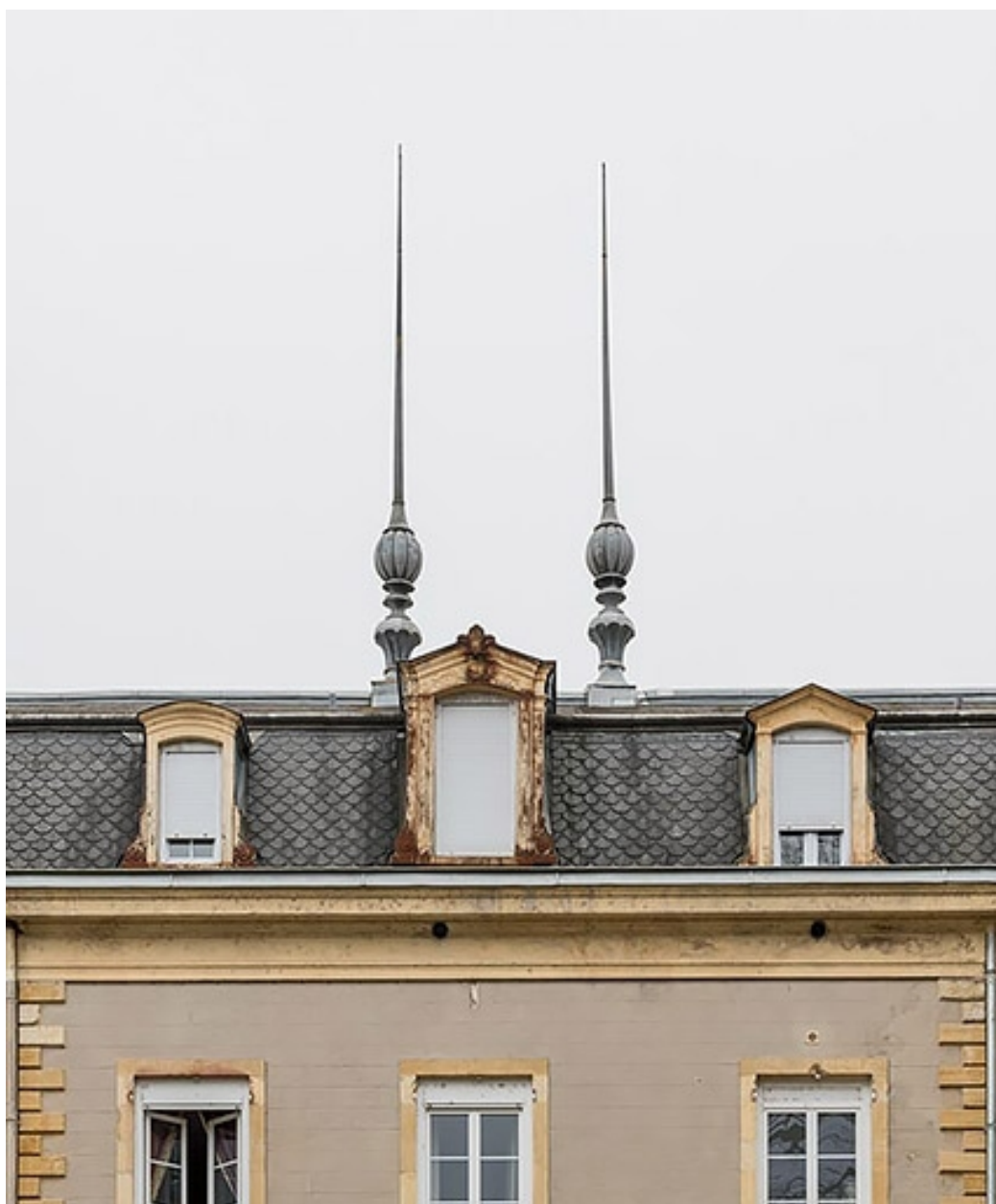
Aile nord, épis de faîtage.
