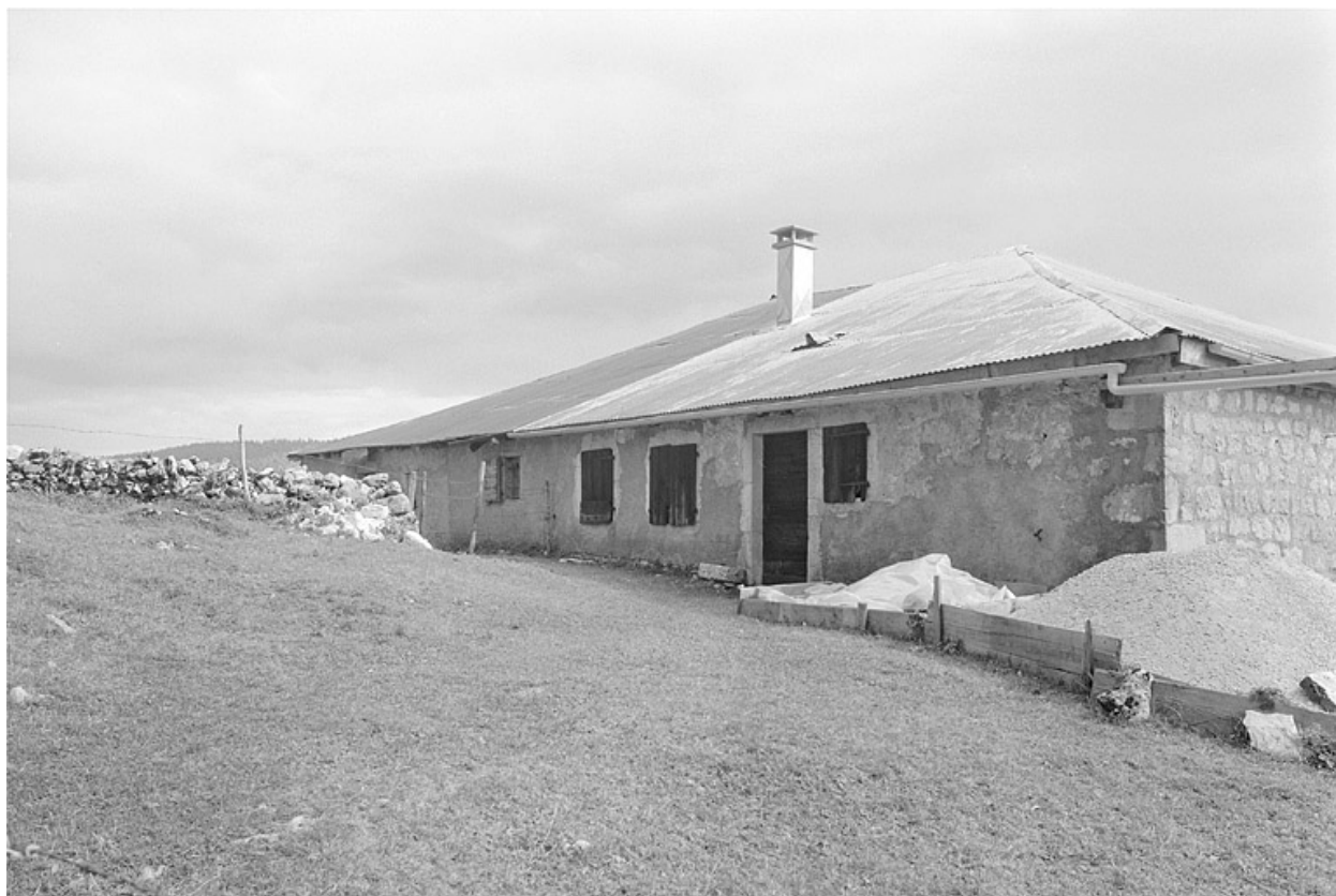
Façade postérieure, vue de trois quarts droit.
