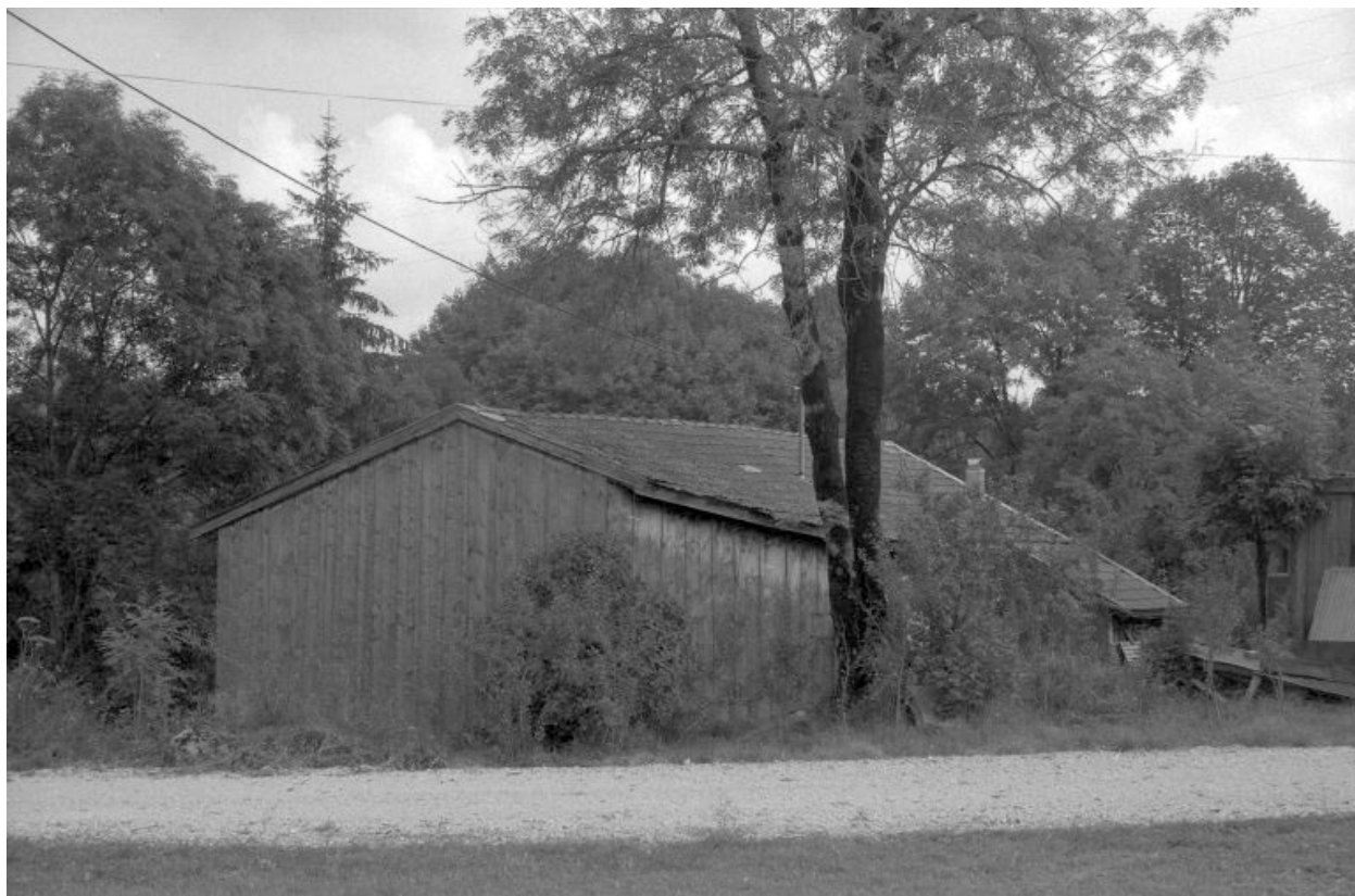
Façades antérieure et latérale droite.
