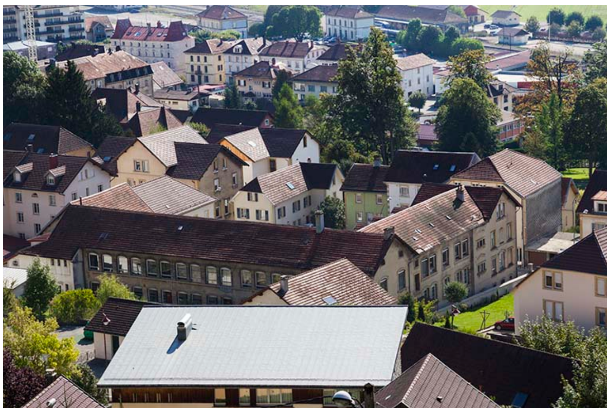
Vue d'ensemble plongeante, depuis le nord-ouest.
