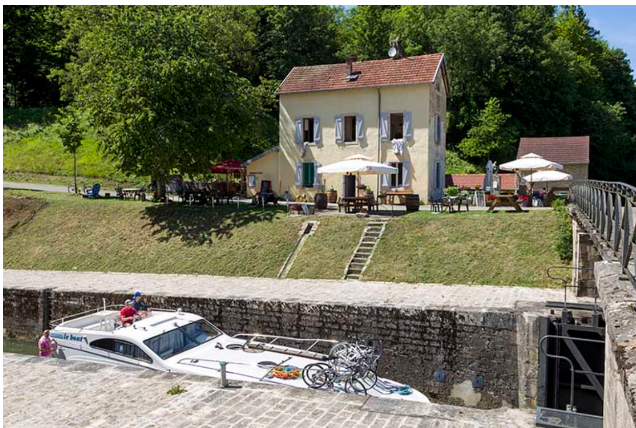
Entrée amont du tunnel Saint-Albin.
