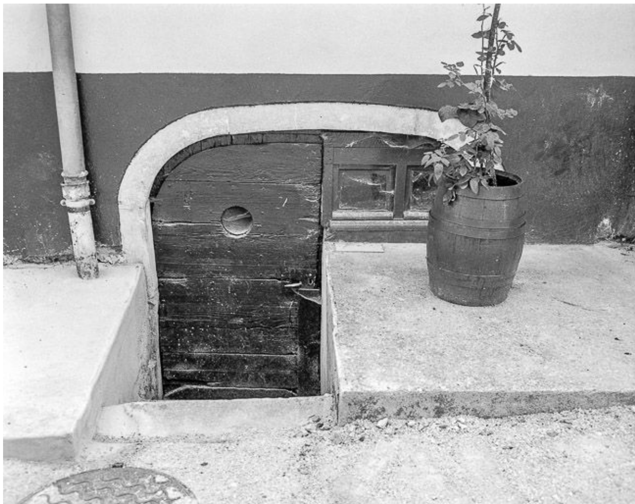
Maison : entrée de la cave.
