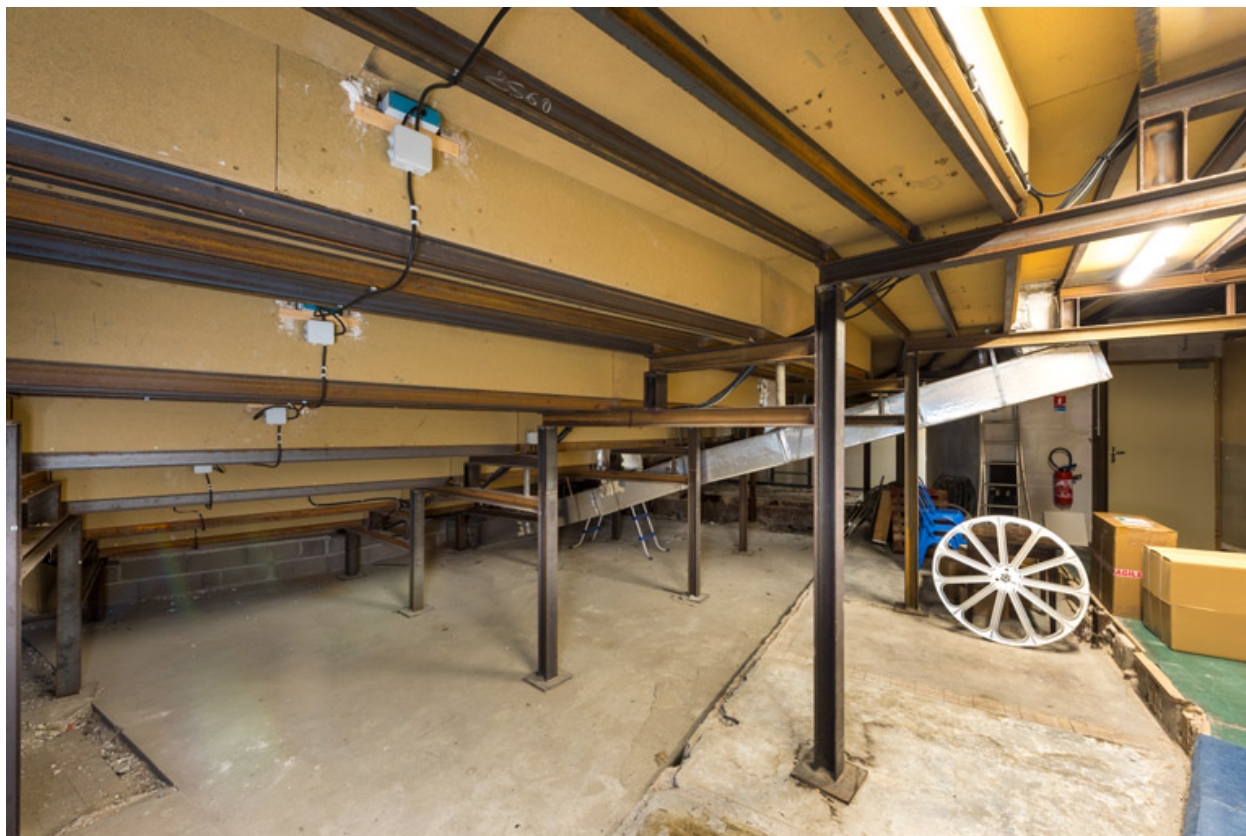
Espace sous les gradins de la salle.
