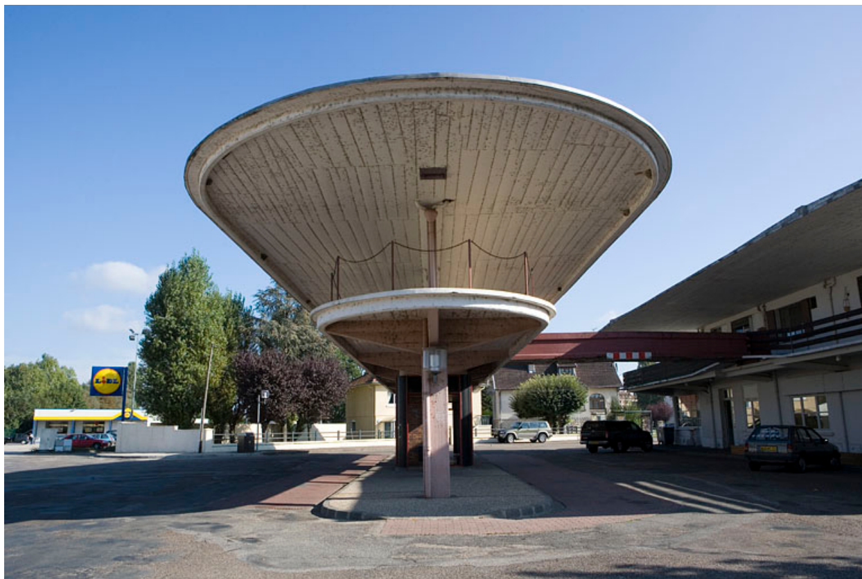
Auvent en béton.
