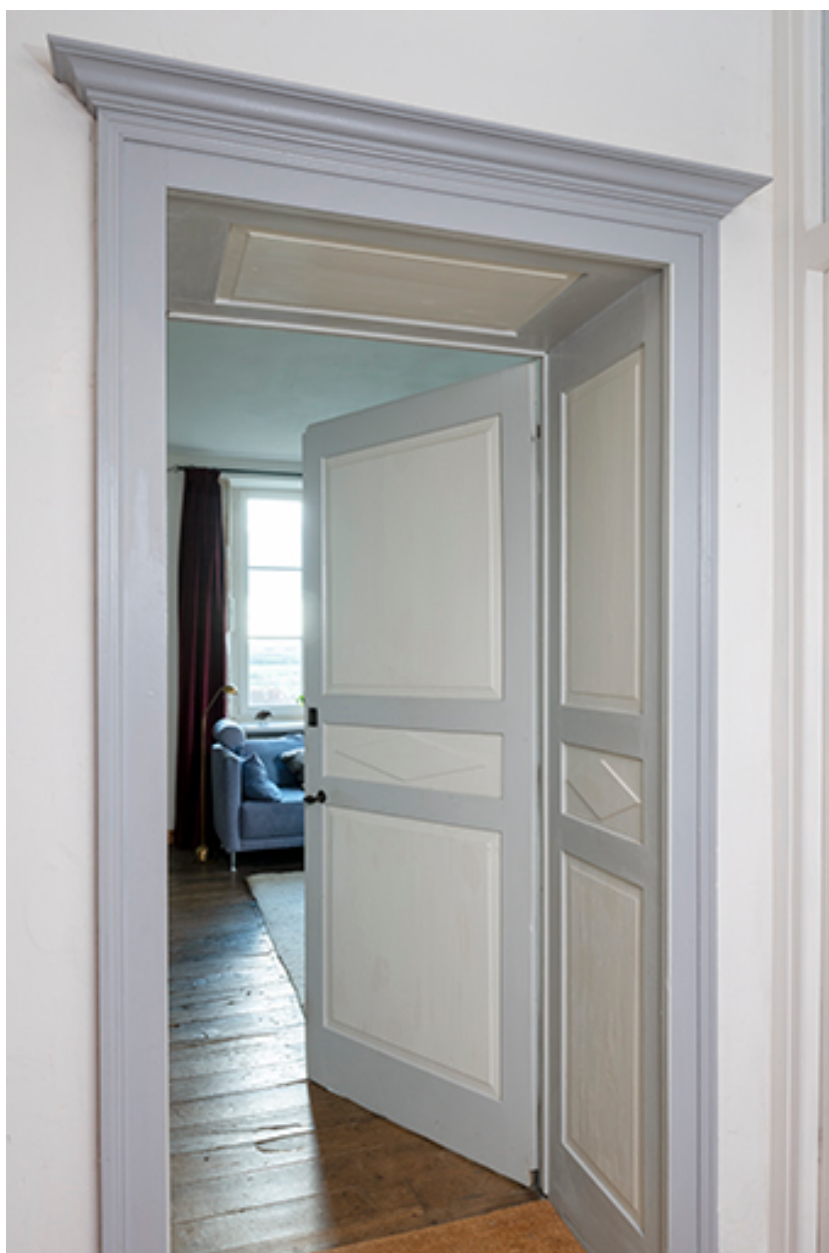
Rez-de-chaussée : détail de baie et menuiserie.
