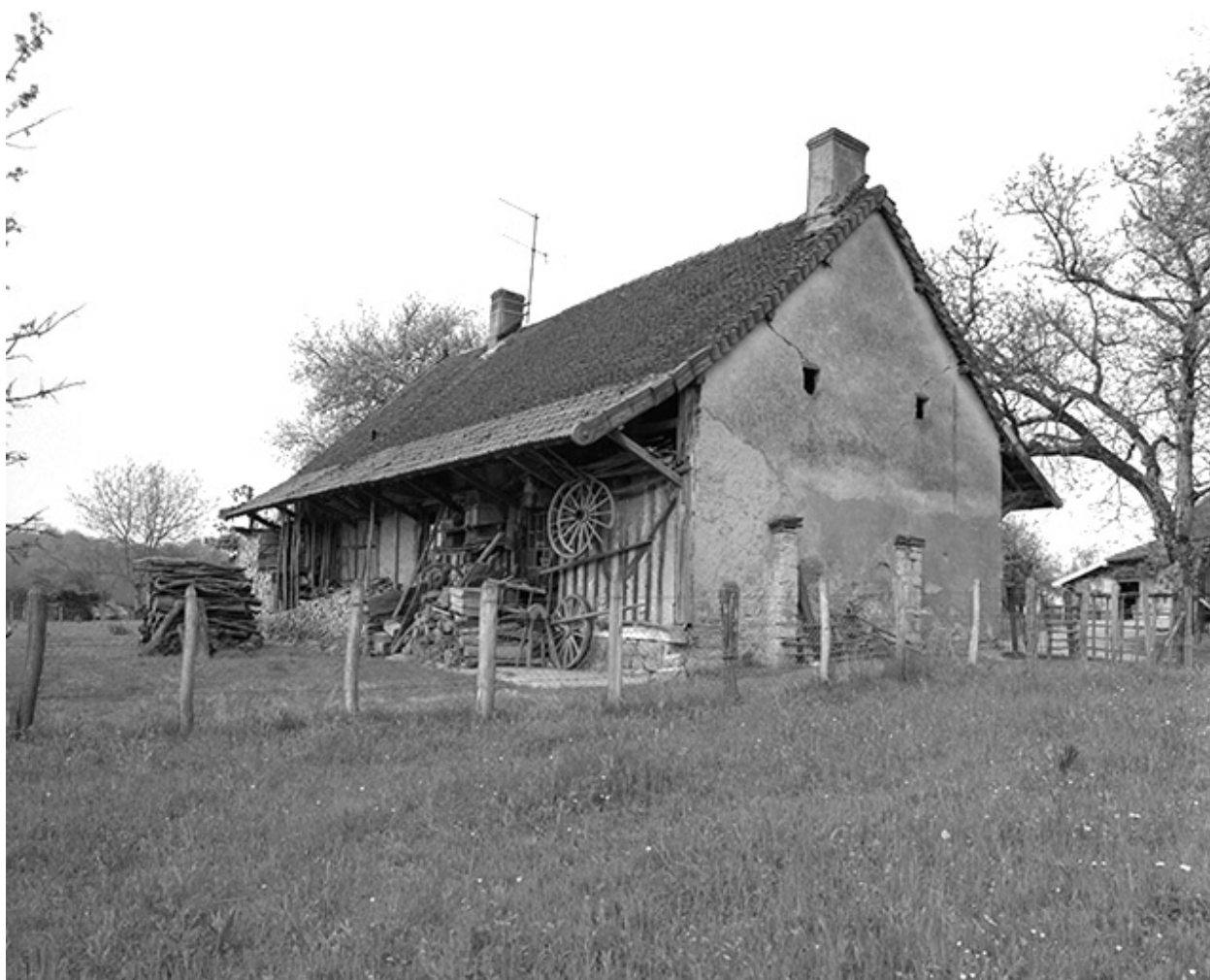
Façades postérieure et latérale gauche.
