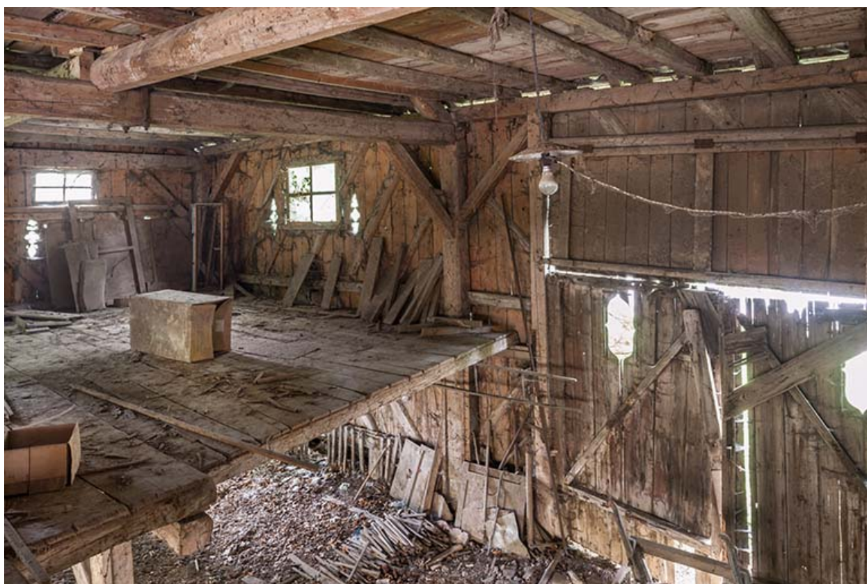
Magasin industriel. Vue depuis l'étage.
