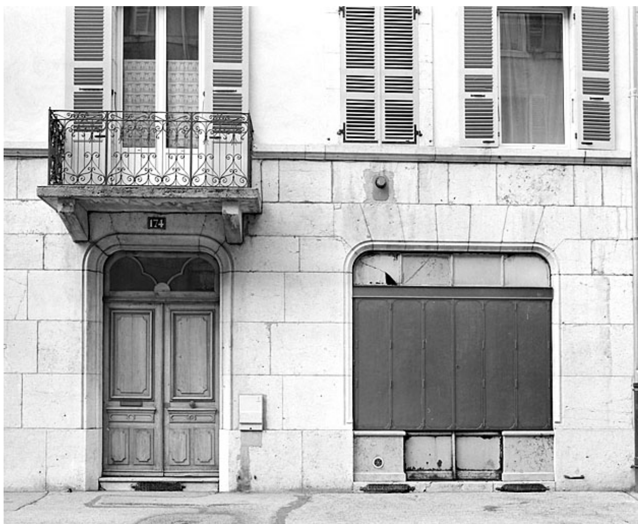
Entrée principale et boutique droite.
