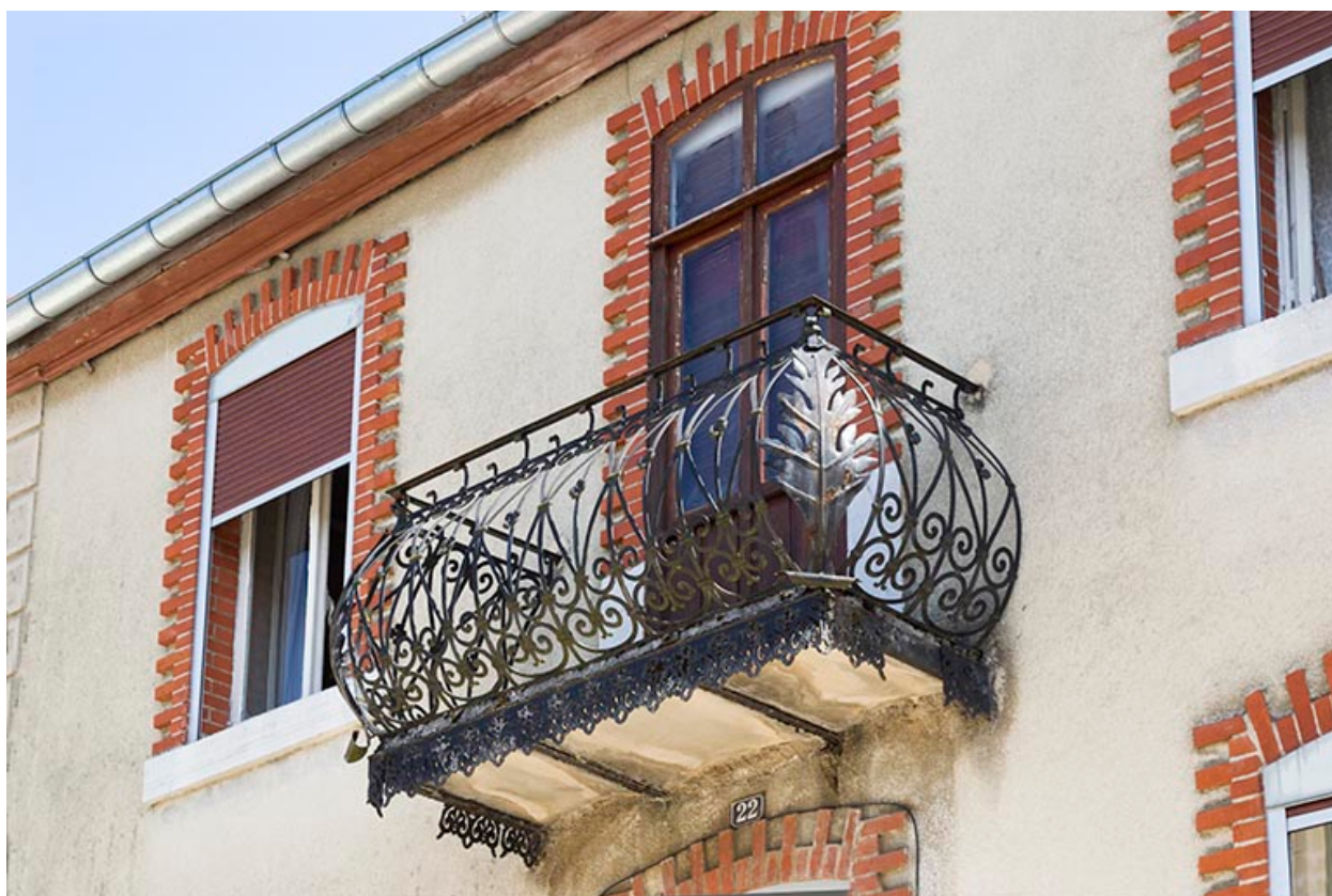
Maison, façade antérieure : balcon, vu en contre-plongée.
