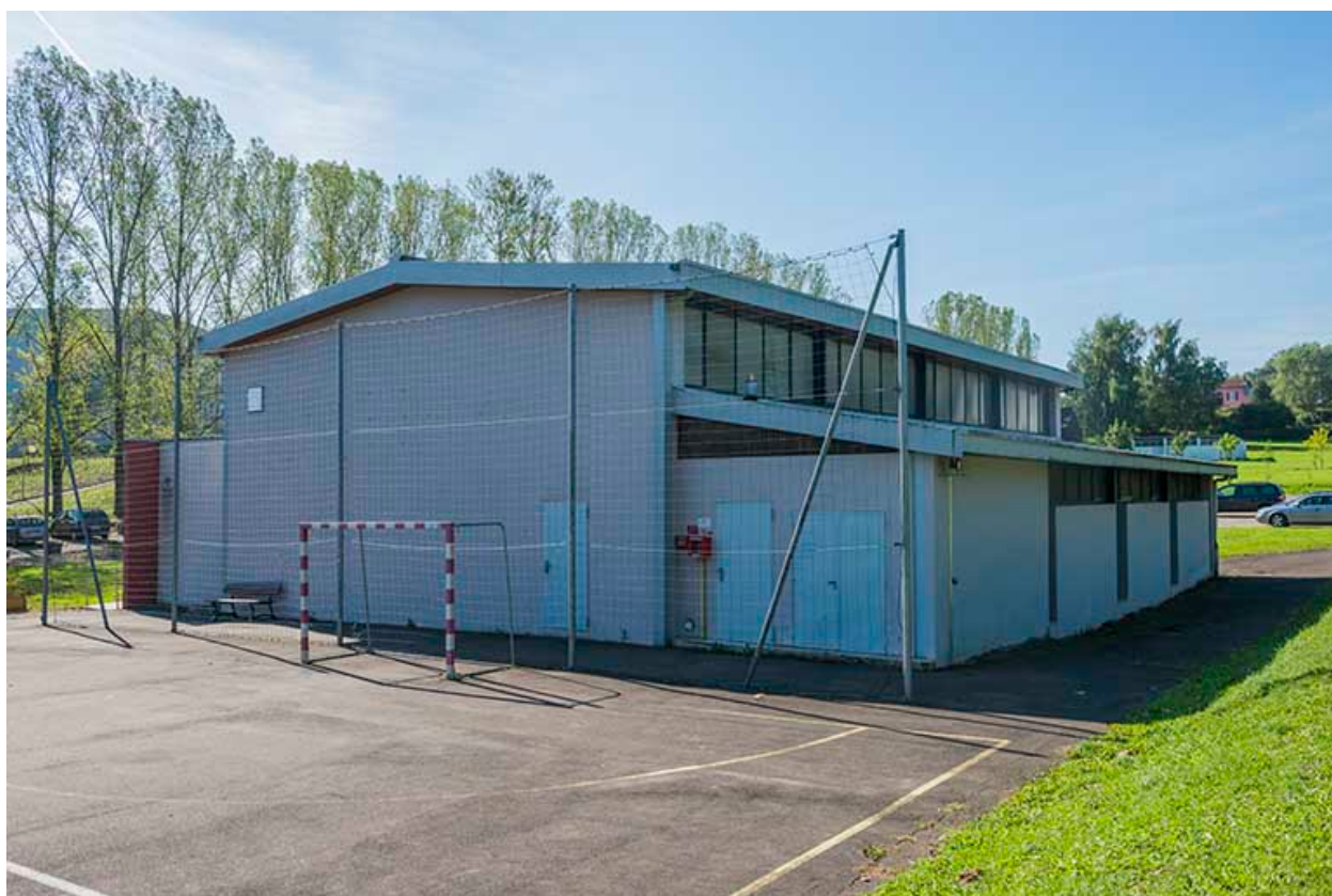
Angle nord et pignon nord-est du gymnase
