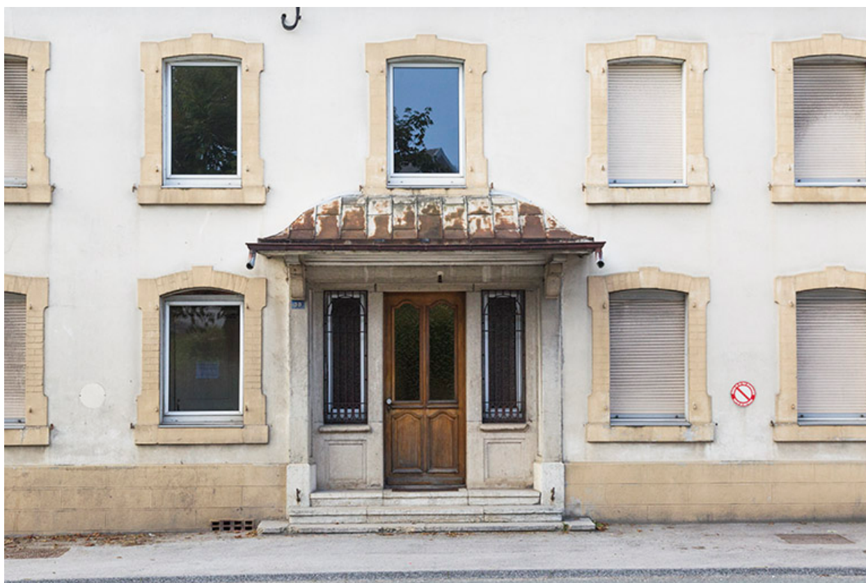
Façade antérieure : entrée de l'atelier de fabrication.
