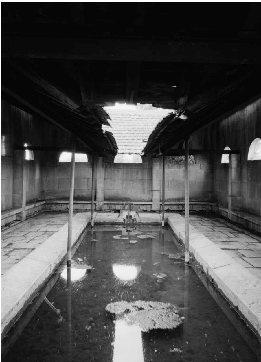
Vue intérieure du lavoir.
