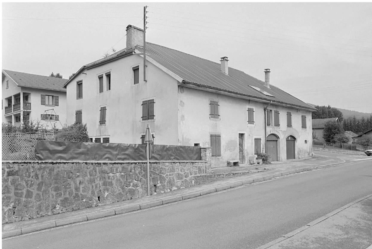
Face sud et façade sur rue.
