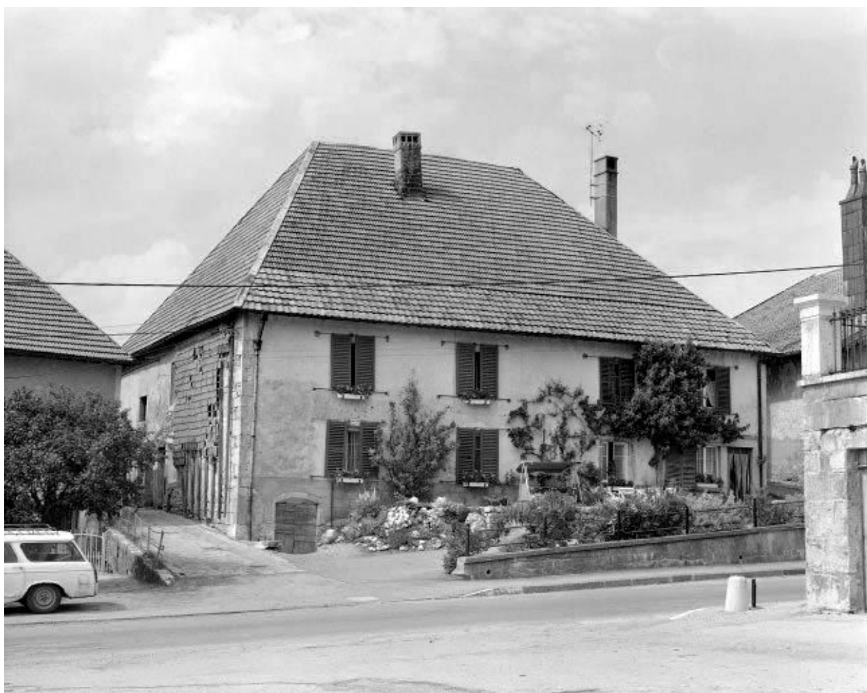
Façades antérieure et latérale gauche.
