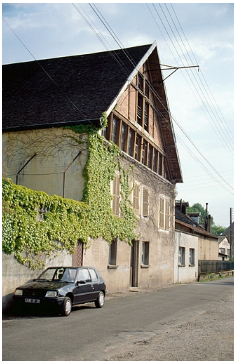
Façade antérieure de l'atelier de fabrication (J).
