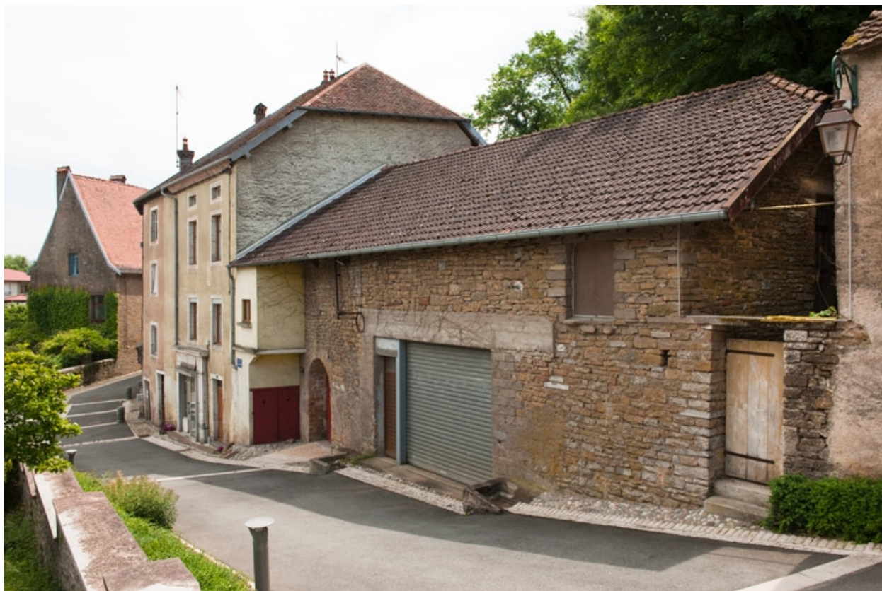
Vue de l'entrepôt commercial.
