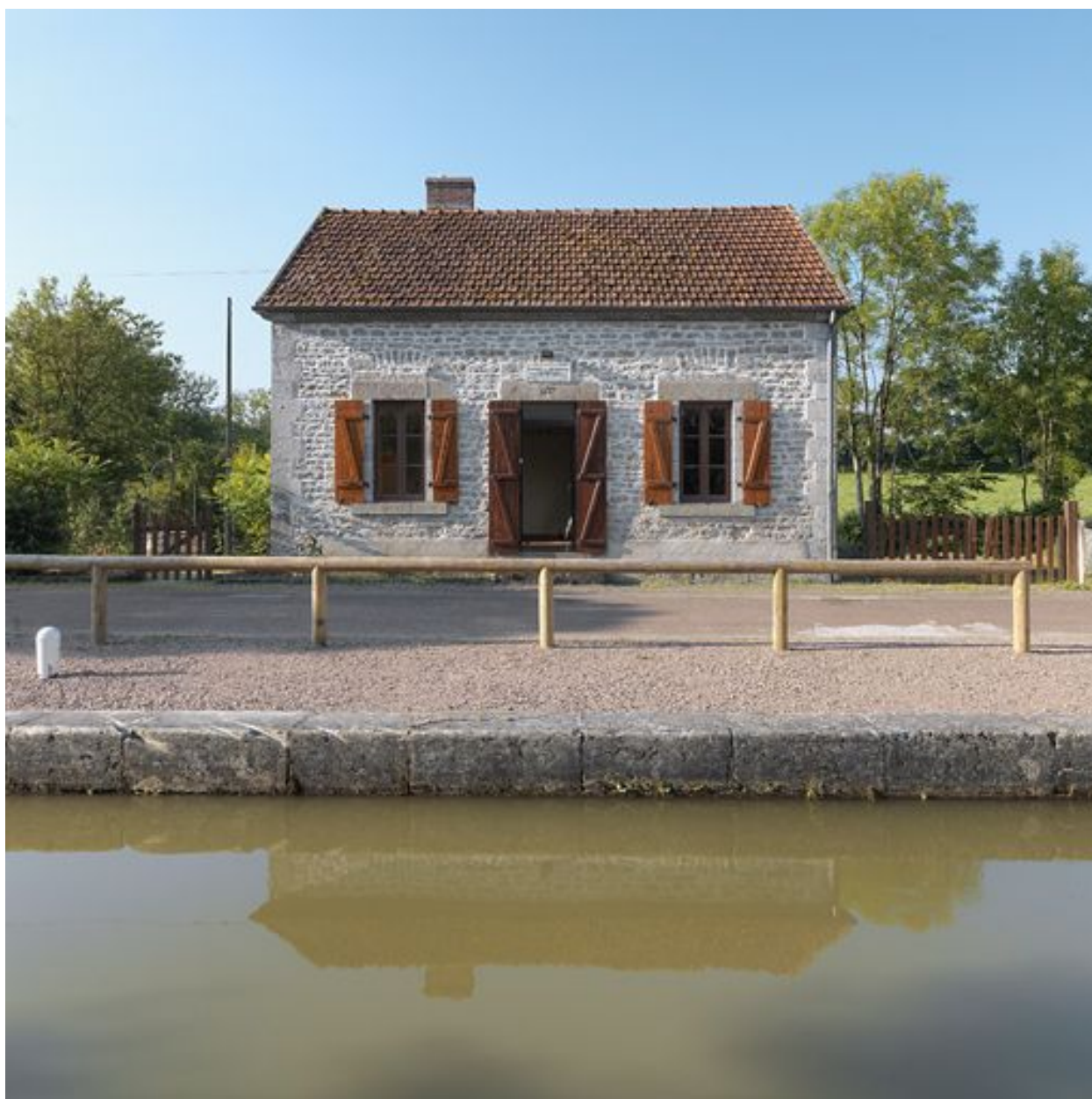
La maison éclusière : vue de face.
