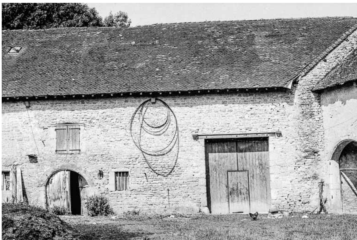
Partie agricole : façade sur cour.
