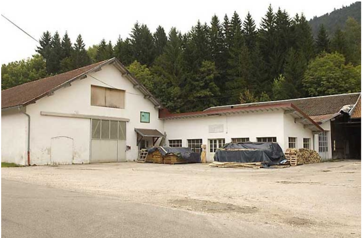
Partie nord : vue rapprochée.
