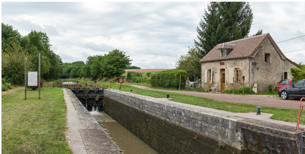
Le site d'écluse.
