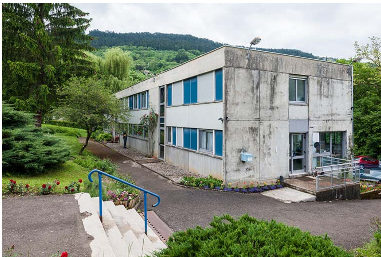
Angle nord-ouest de l'administration.
